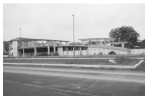
22. Stazione Rebaudengo Fossata
